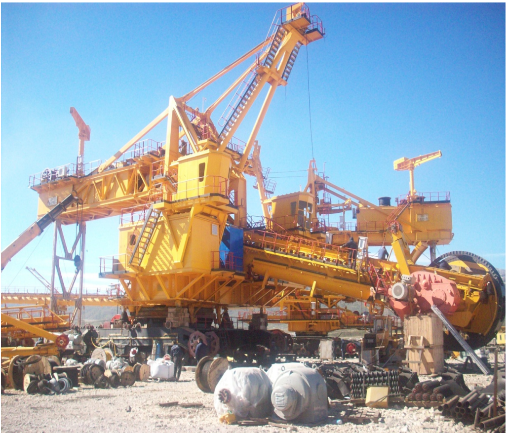
Sl. 9 Rotorni bager ER 1250/17 u završnoj fazi montaže
