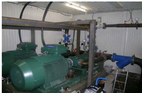
Sl. 6 Sklop vijčane pumpe i elektromotora [1]
